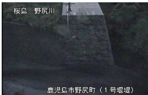
野尻川1号堰堤右岸 5:35 頃
