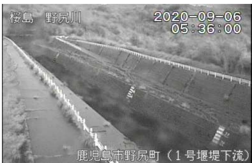
野尻川1号堰堤下流 5:36 頃
